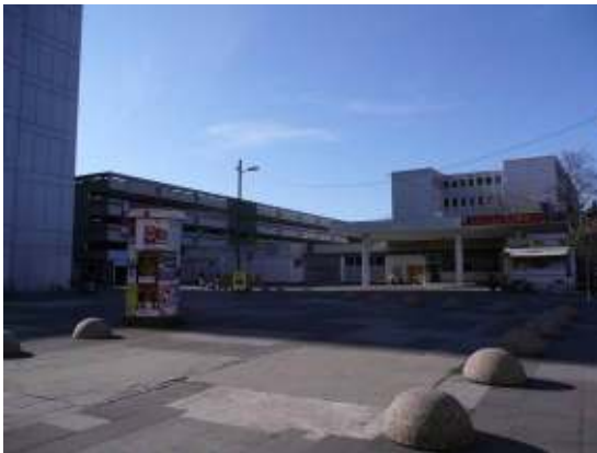
Abbildung 57: Zugang Parkhaus Schuhstraße (rückwärtiger Bereich (Nürnberger Straße))
